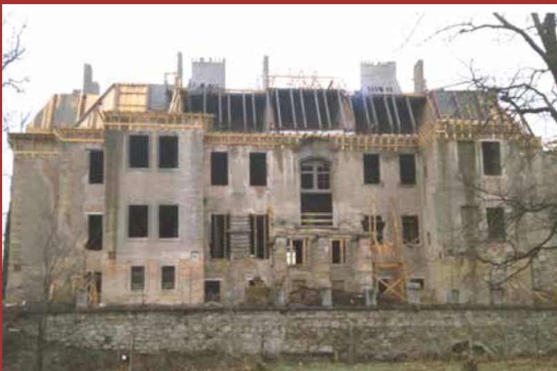
Unterstützt von Polen und Deutschland, geht es ab 1990 an die Sanierung. Das Gut soll Jugendbegegnungsstätte werden.
