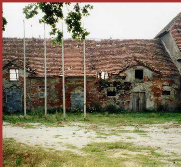
Nach dem Krieg verfallen das Schloss und die Gutsanlage Kreisau zusehends.
