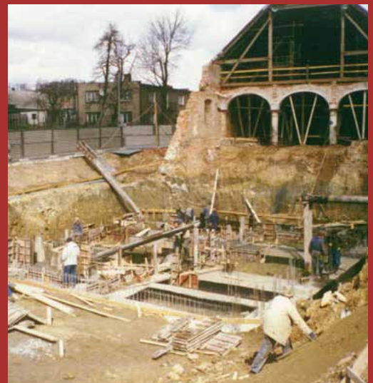
Auch die Hofanlage wird wiederaufgebaut und grundlegend erneuert.
